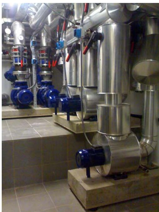
Fig. 10 . elettropompe centrale frigorifera con basamento
